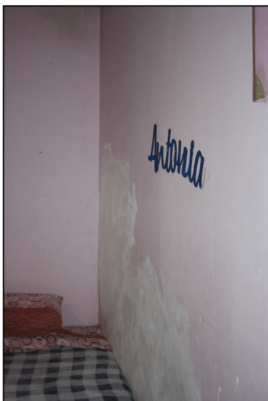
Foto 10- 11– Camera da letto con problemi di infiltrazioni d'acqua
